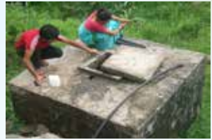
खानेपानीको ट्यांकीमा क्लोरिन मोल राखिएको (जाजरकोट, २००९)
