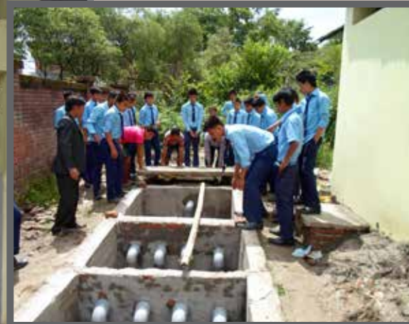
Construction of ABR
